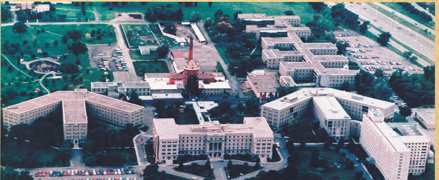
Site actuel dont la construction a débutée en 1897.
